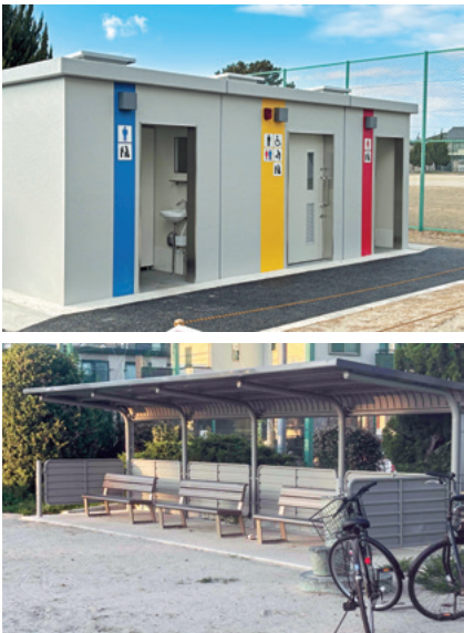
八家公園の新設トイレ(上)と屋根付きベンチ
