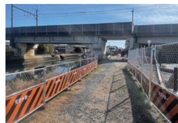
砂利道舗装工事
