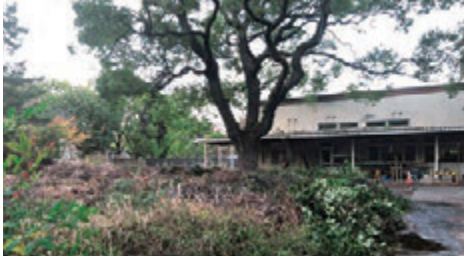
物置と化した土木事務所と枯れ木置き場 ＝令和元年6月撮影
